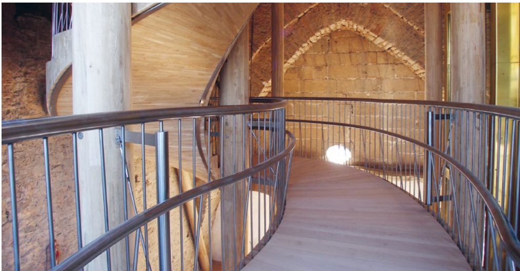
Aufgang und Rundpfeiler aus Eichen-Brettschichtholz, Kathedrale Santa Maria, Vitoria (Spanien)
