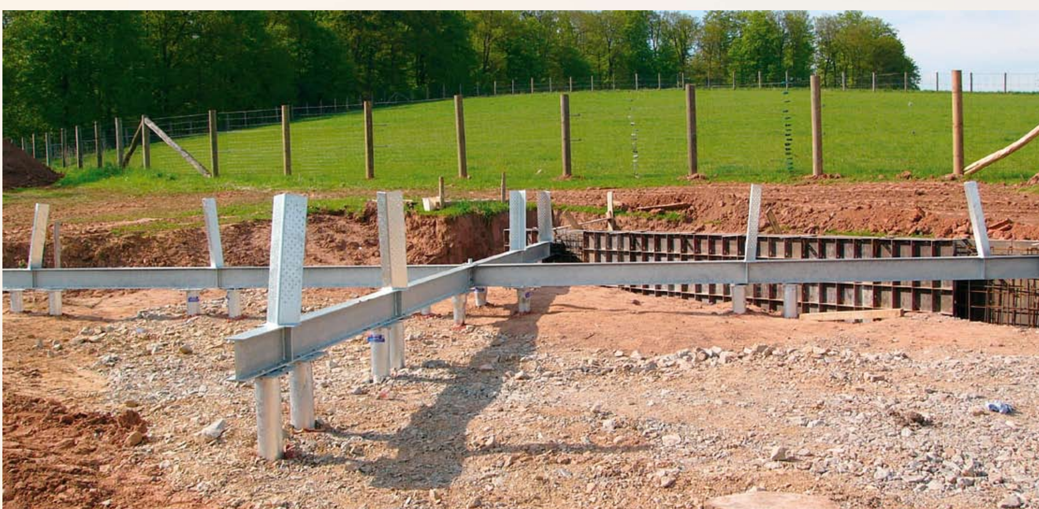
Blick auf die Eisenkonstruktion der Fa. ASS Stratemeier aus Warburg-Scherfede und auf die Stütz- mauer, gefertigt von der Fa. Eickhoff, Lichtenau-Kleinenberg
