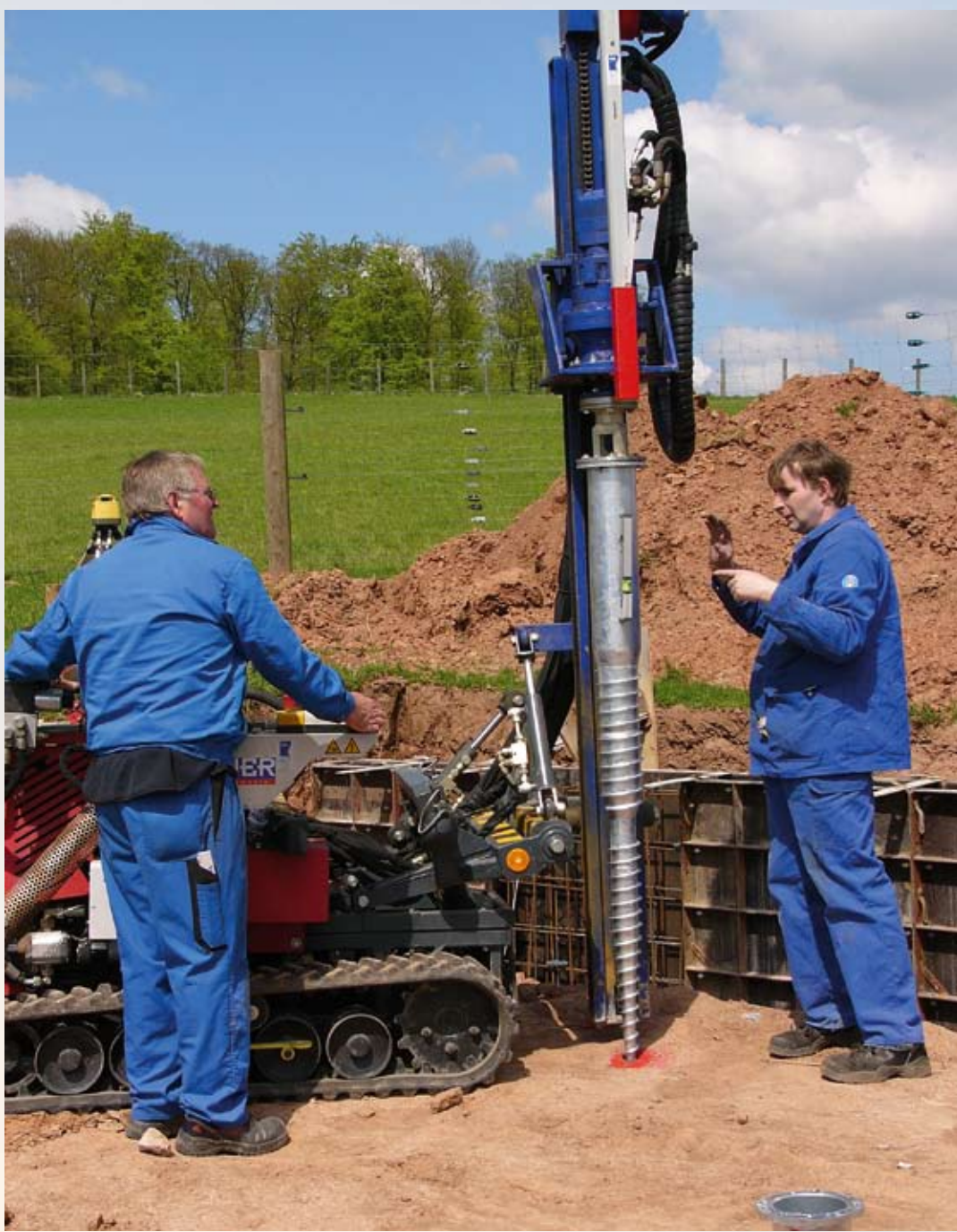
Mitarbeiter der Firma Ikemeyer, Paderborn, bohren die Erddübel ein
