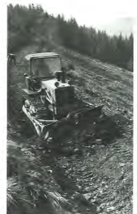
Wegebau im Bauernwald bei Plettenberg-Bremke (Photo: Archiv FoDoS)
