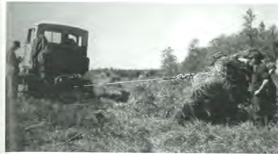
Stubbenräumung durch Rodeschlitten im Reichswald (Photo: Gorissen 1950)
