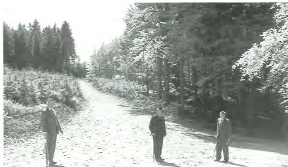
Wegeabnahme des Holzabfuhrweges Ehringhausen mit Hr. Feldhaus und dem Vorsitzenden der WWG (Photo: Archiv FoDoS)
