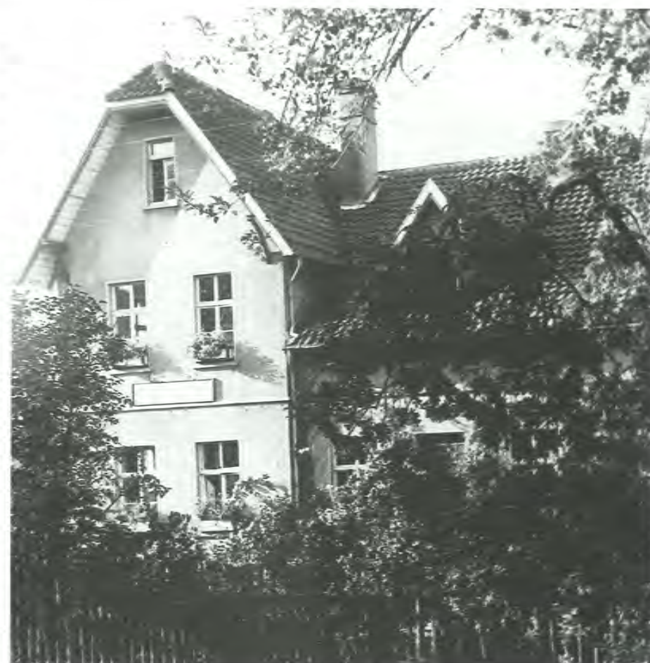
Forstschulgebäude in Ehringhausen (Photo: Archiv FoDoS)
