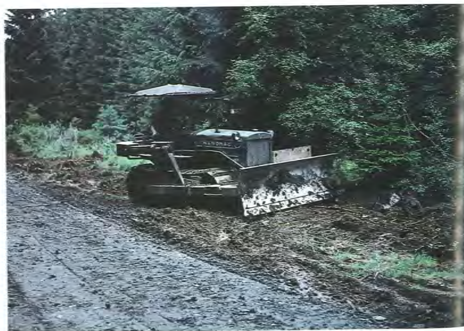
Planierraupe beim Bau des Otto-Weller-Weges, Wiederstein 3.7.1959 (Photo: Dr. H. Mudrich)
