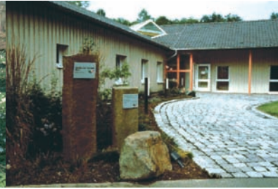
Betriebsgebäude Bonn-Röttgen des Regionalforstamtes Rhein-Sieg-Erft
