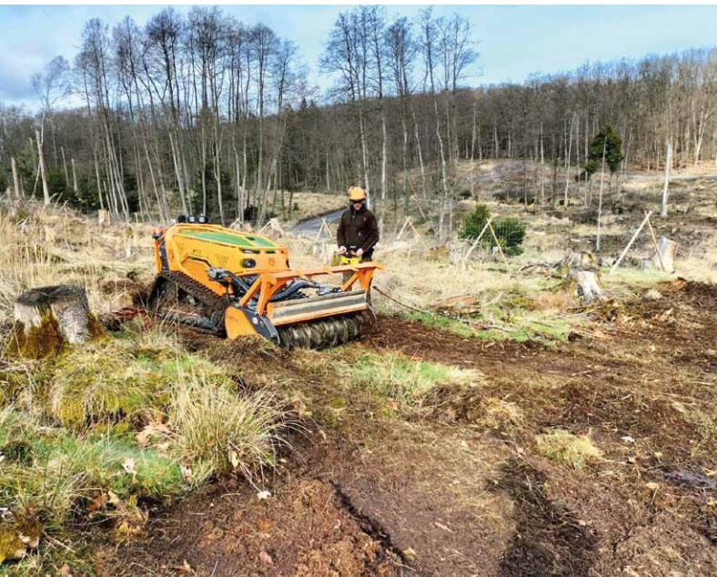
Schonende Bodenvorbereitung mit Kleinmaschinen und geringem Bodendruck ohne Rodung der Fläche.
