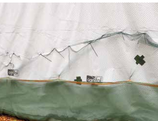
Kleinere Schäden können mit Gewebeband repariert werden.
