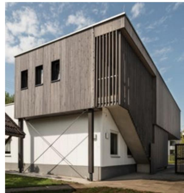
Für die Fassade wurde regionale Douglasie aus einem benachbarten Sägewerk verwendet. Mittels Silikatfarbe bereits vorvergraut, garantiert sie langfristig eine attraktive wartungsarme Optik.
