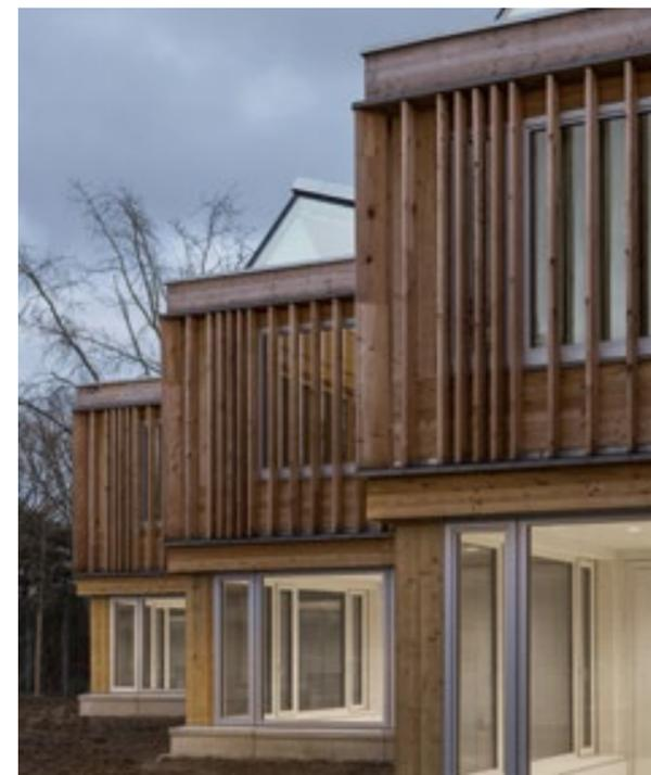
Vertikale Lärchenholzlamellen der Fassade, ergänzt durch innenliegende Blend- und Sonnenschutzvorhänge im Obergeschoss sowie außenliegende Screens im Erdgeschoss, stellen den sommerlichen Wärmeschutz sicher.
