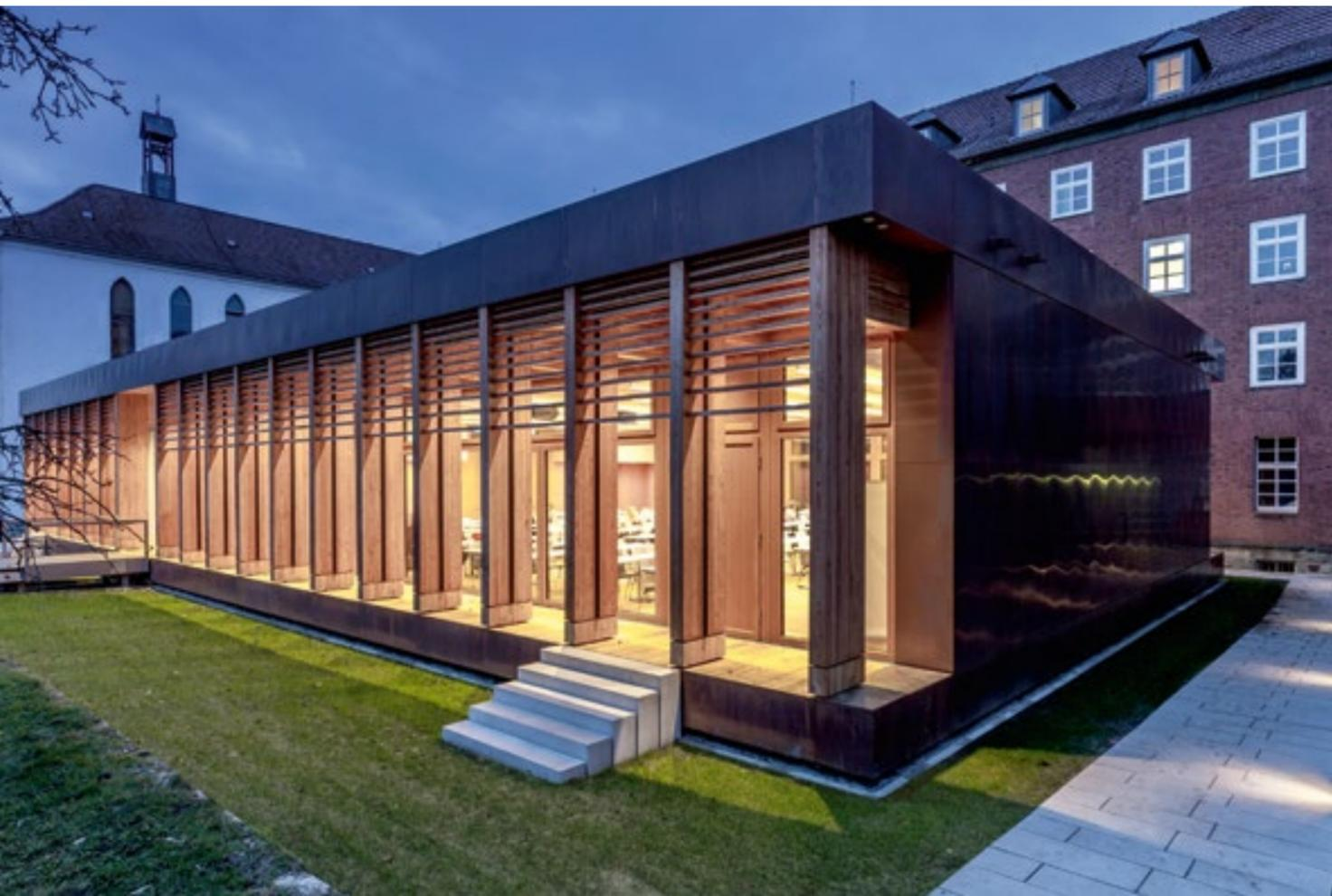
Die Hörsäle und Seminarräume werden über raumhohe Glasfronten belichtet. Der Sonnenschutz auf der Südseite wird vom überstehenden Dach und Holzlamellen im oberen Bereich gewährleistet.
