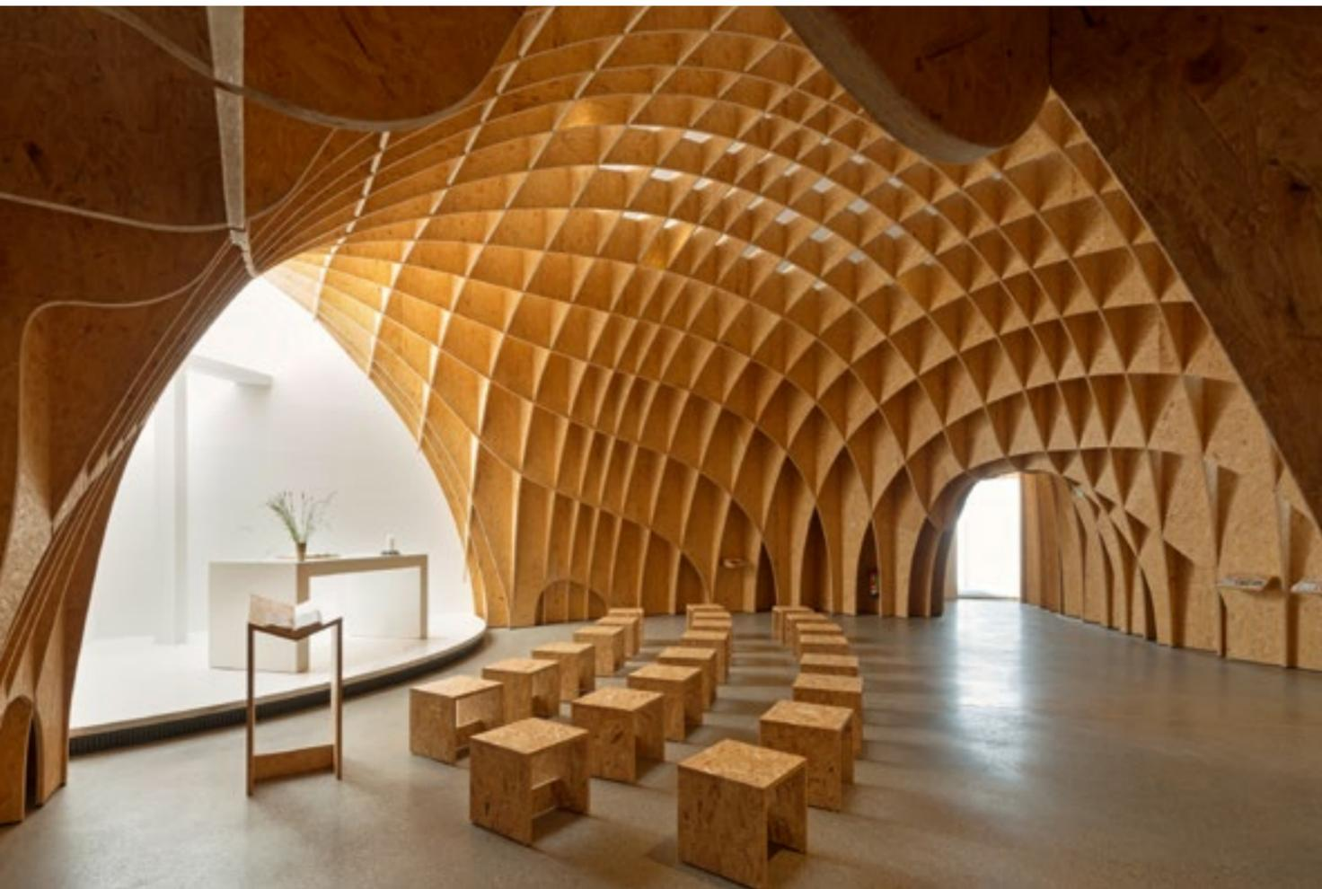
Die Innen- und Außenseiten der Holzkonstruktion wurden mit OSB-Platten verkleidet. Die Brückenwände bestehen aus einer Holzfachwerkkonstruktion und der Brückenboden aus Stahlträgern mit beidseitiger OSB-Beplankung. Die Fassade der Kirche und der Verbindungsbrücke wurden mit einer weißen Polyurethan-Sprühabdichtung versehen. So wurden die Außenflächen des Holzes gegen Feuchtigkeit und Beanspruchung geschützt, und dem Gebäude wurde ein homogenes Erscheinungsbild verliehen.
