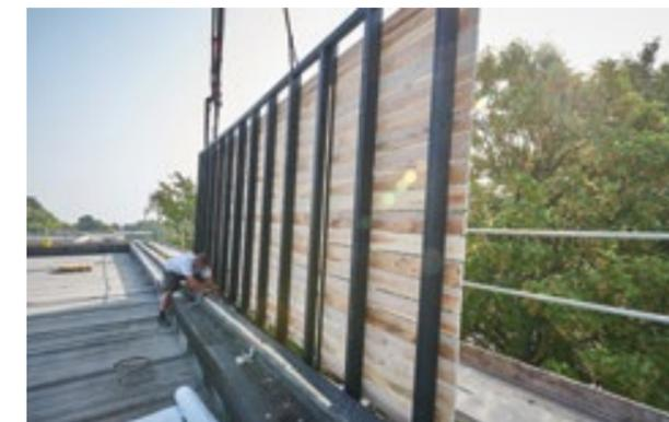
Optimierter Bauablauf: schnelle Montage der hinterlüfteten Leistenfassade auf die bereits aufgebrachte Dämmschicht auf der Baustelle.
