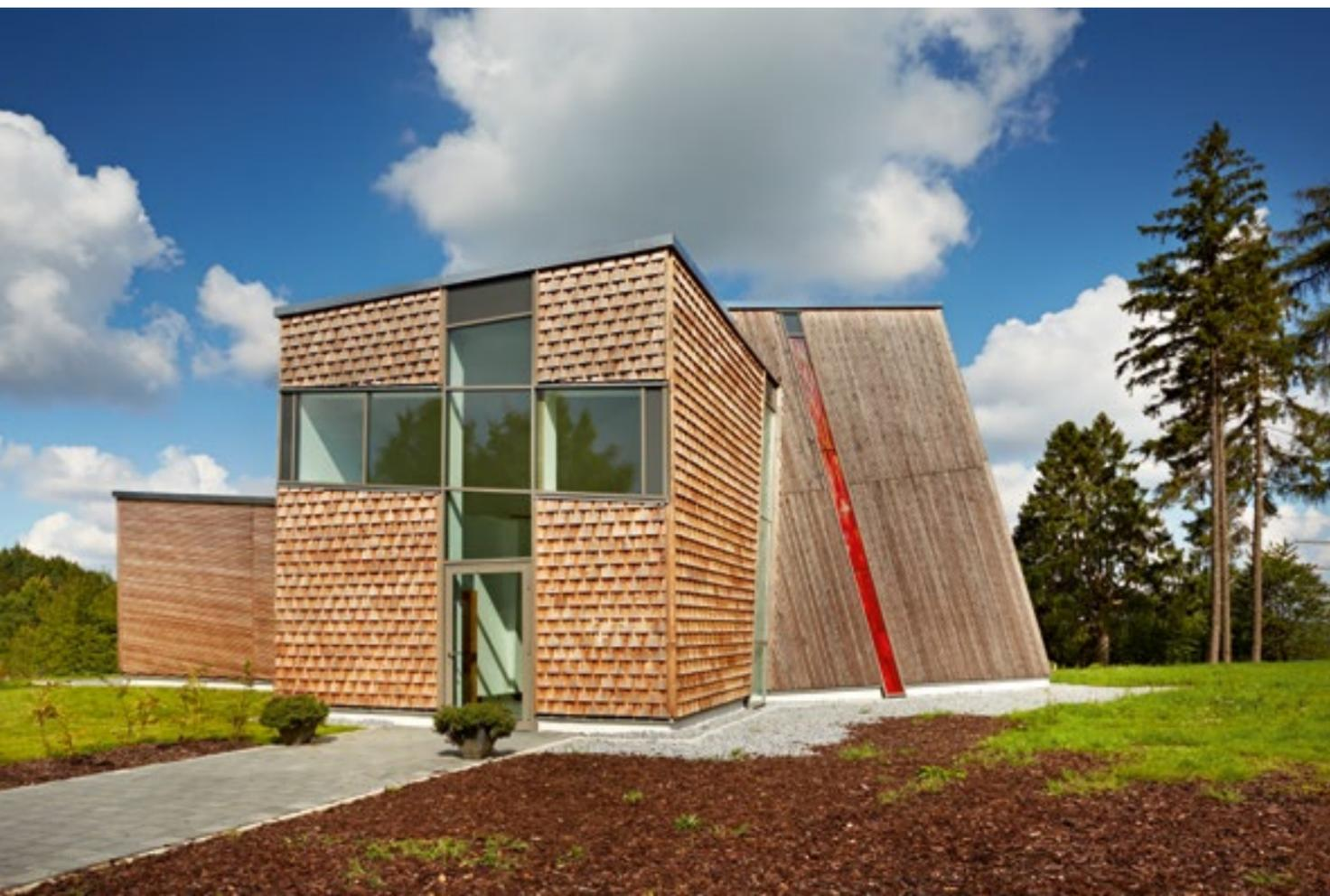
Die Kapelle wurde in Holzrahmenbauweise errichtet. Ein von außen besonders markantes Merkmal bildet die Gebäudehülle aus unbehandelter Lärche. Ein Kubus wurde mit einer Holzfassade in Form von Holzschindeln verkleidet. Die anderen beiden Würfel erhielten eine Holzfassade aus vertikalen und horizontalen Rhombusleisten. Das Gebäude entstand mit großem Engagement und durch erhebliche Eigenleistung – unter anderem durch 5.000 Stunden ehrenamtlicher Arbeit – der Pfadfinderinnen und Pfadfinder.
