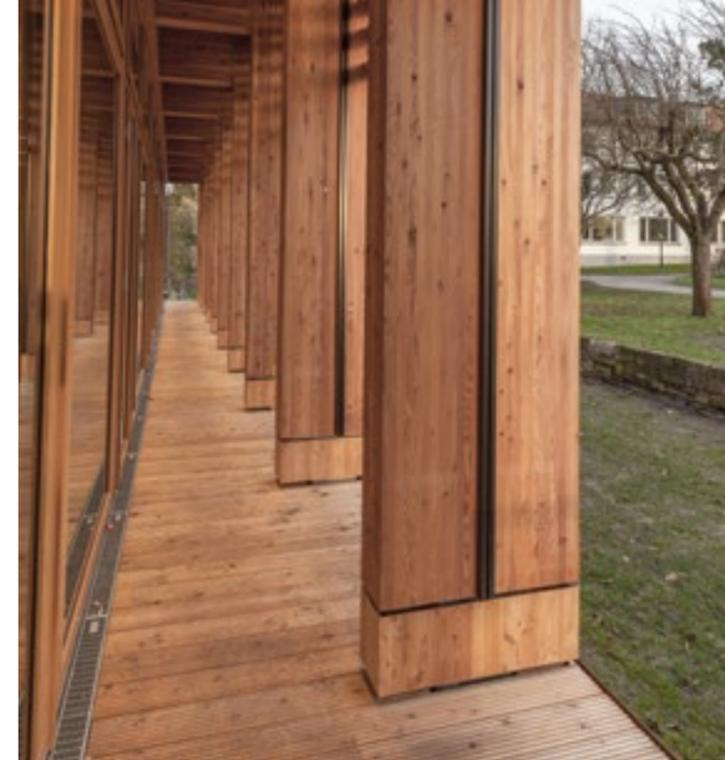
Die außenliegenden Stützen der Hauptrahmen sind bewittert. Der konstruktive Holzschutz wird unter anderem durch die Verwendung von splintfreiem Lärchenholz gesichert. In den der Witterung ausgesetzten Bereichen gibt es keine horizontalen Flächen – ein chemischer Holzschutz war somit nicht notwendig.
