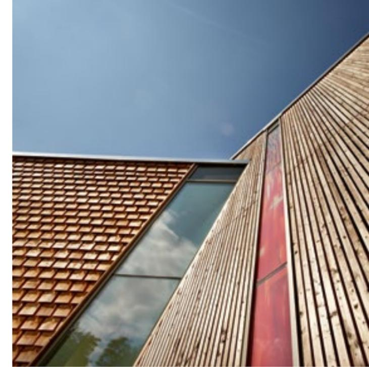
Die Holzfassade aus unbehandelten Lärchenschindeln prägt den Charakter des Eingangsgebäudes und bildet einen ansprechenden Kontrast zu den vertikalen und horizontalen Lärchenleisten.
