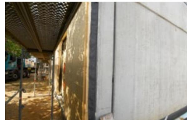
Präzise Ausführung: exakter Aufbau der im Werk vorgefertigten Fassadendämmung auf den Bestand.
