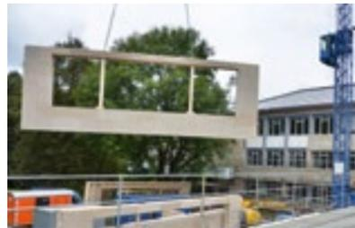
Durch die Bauweise mit vorgefertigten Elementen aus Brettspertholzplatten konnte die Bauzeit mindestens halbiert werden.
