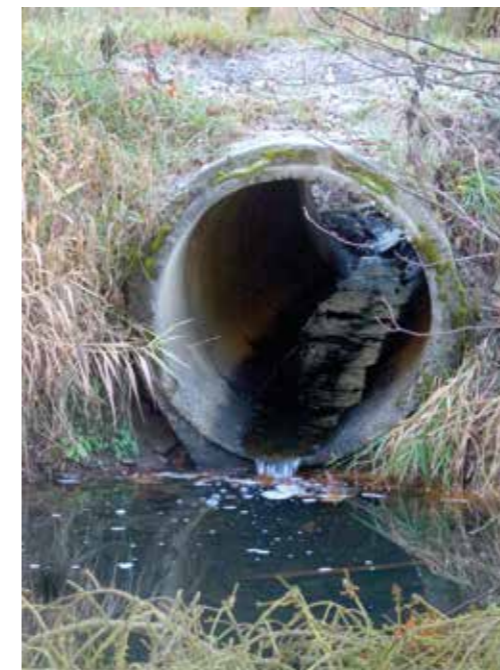
Abb. 5: Störstelle durch Sohlabsturz
