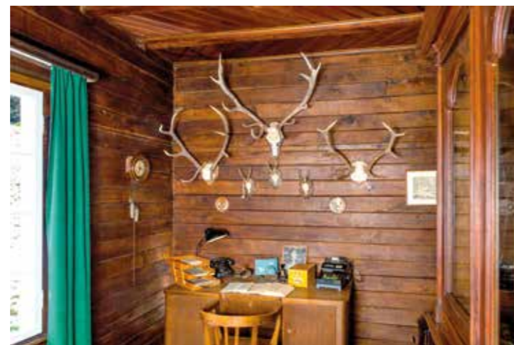
Abb. 5: Ein Blick in das Arbeitszimmer in der Ausstellung im Forsthaus Broichen. Auch von innen ist die Blockbauweise des Holzhauses gut sichtbar.
