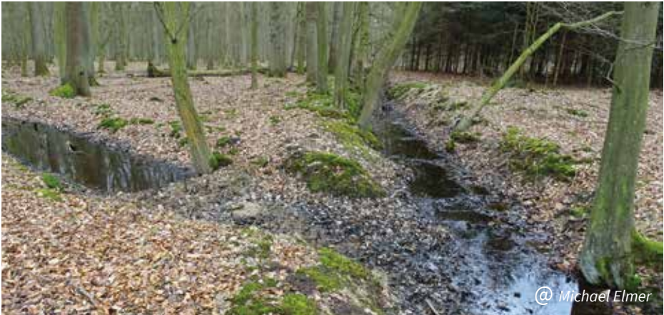
Mit einem Lehmstau verschlossener Entwässerungsgraben (links) verhindert den Wasserabfluss in einen größeren Graben
